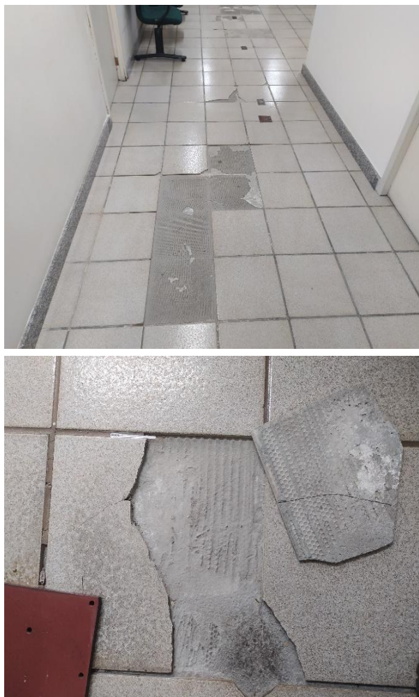
Figura 8. À esquerda: deslocamento no 3º andar, recepção e à direita: deslocamento no 3º andar, copa.
